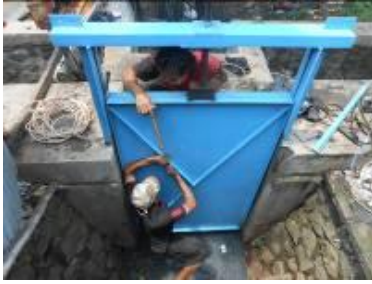
Gambar 12 Perbaikan Pintu Air Di Kelurahan Duri Kosambi
