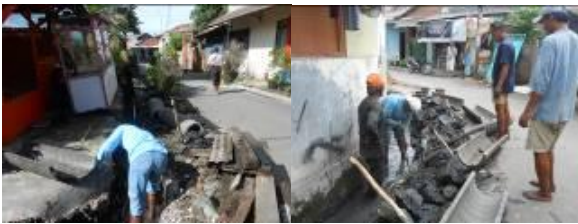
Gambar 13 Perbaikan Saluran Drainase Di Kelurahan Duri Kosambi
