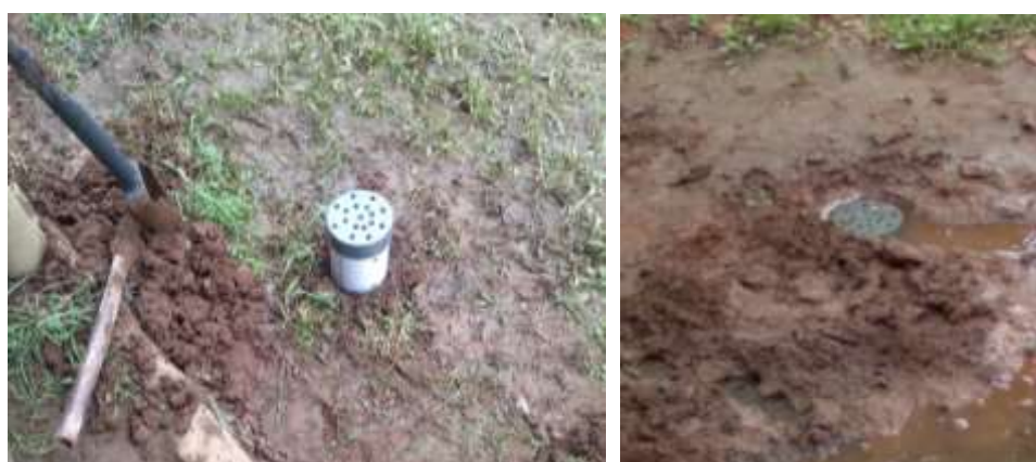
Gambar 5. Hasil praktik pemasangan biopori
