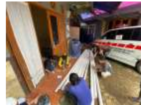
Gambar 9. Perakitan instalasi air
