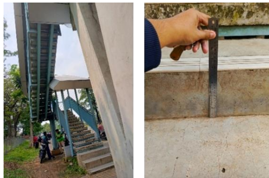
Gambar 2. Proses Observasi Jembatan Penyeberangan
