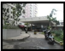
Kurang disiplinnya pengguna motor yang parkir di bukan tempatnya seperti Plaza
