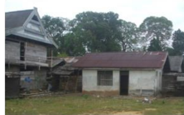
Gambar 1. Kondisi Bangunan Tempat Tinggal
