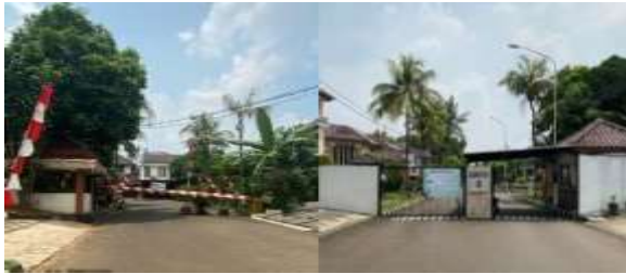
Gambar 16 Fasilitas Keamanan Perumahan Bintaro Jaya Sektor 6
