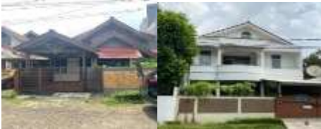
Gambar 34 Fisik Bangunan Hunian di Perumahan Bintaro Jaya Sektor 5
