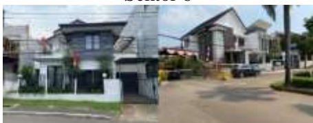
Gambar 36 Fisik Bangunan Hunian di Perumahan Bintaro Jaya Sektor 9
