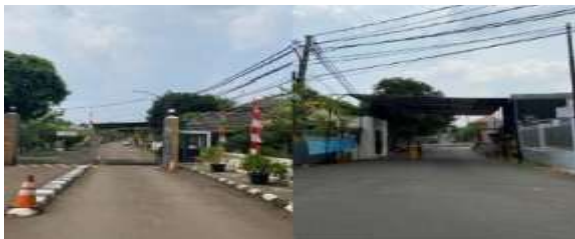
Gambar 17 Fasilitas Keamanan Perumahan Bintaro Jaya Sektor 9
